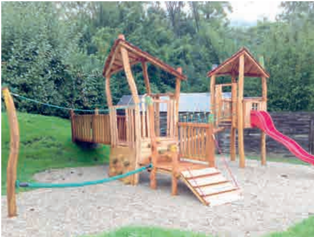
Doppelturmanlage Purkersdorf RO1017.00
